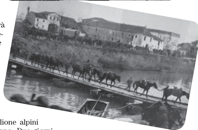
Costruzione di una passerella sul fiume Livenza (Motta di Livenza), Piacenza, Archivio del 2° Reggimento Pontieri.
